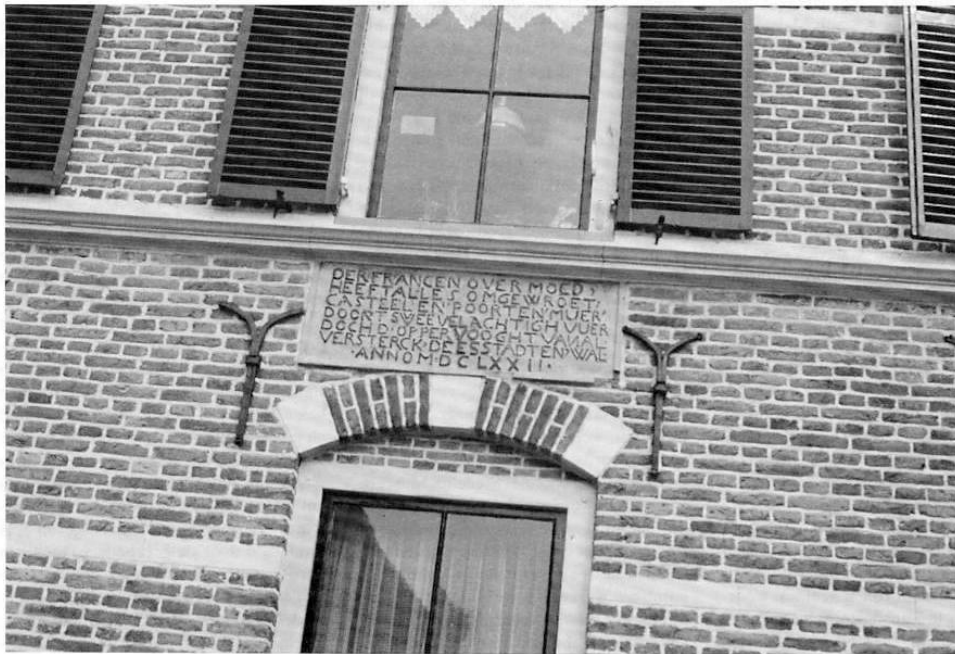
2. Gevelsteen op De Markt in Hatterem naar aanleiding van het Rampjaar.
