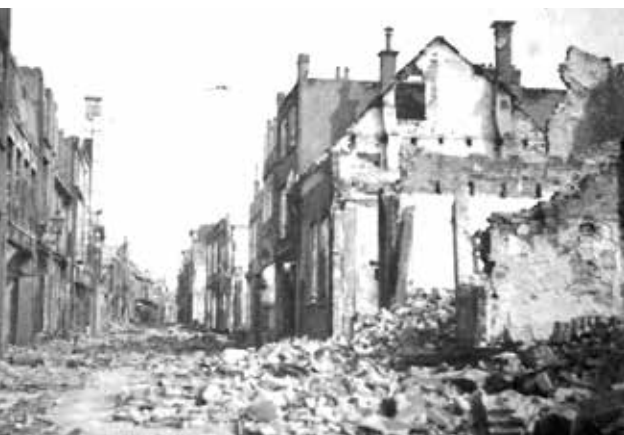
Verwoest Tiel, Waterstraat (Collectie: OKT)
