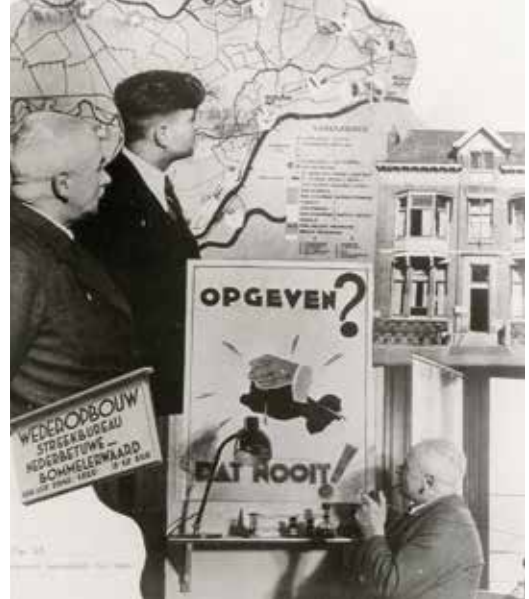
Montage foto Streekbureau voor de Wederopbouw, Kalverbos 5 (Collectie: Fest)
