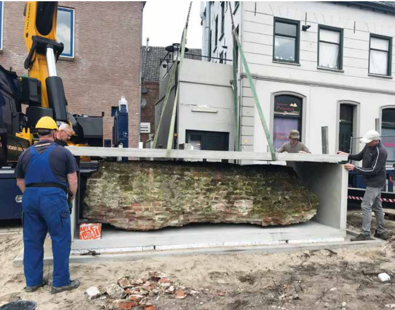
Het plaatsen van een fragment van de middeleeuwse stadsmuur op 30 september 2020. (Foto: Tineke Swaneveld)
