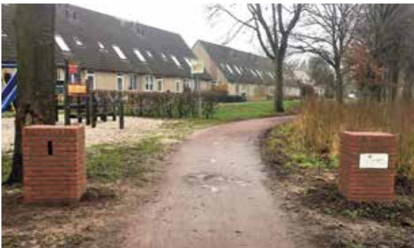
♣ Eierland gerenoveerd (Foto auteur)
