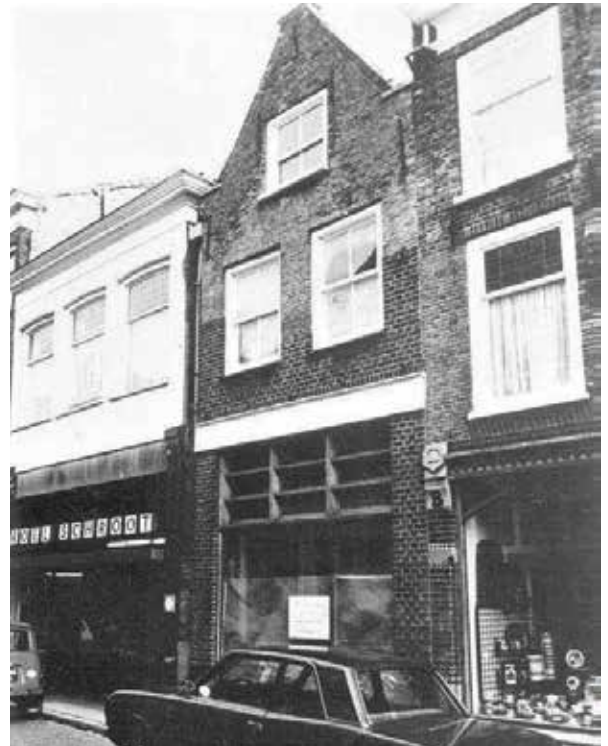
⚠ Het linkergedeelte van nr. 39 in 1970 (Foto RAR)
