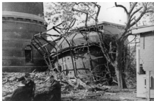
Het naar beneden gestorte waterreservoir
