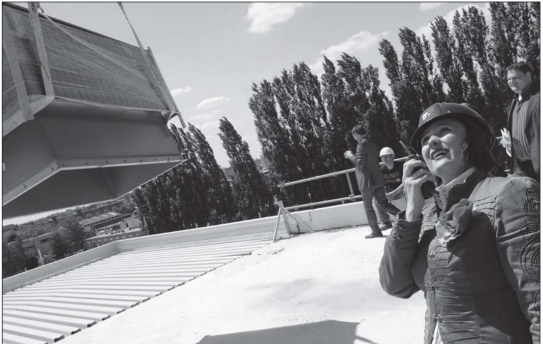
Het plaatsen van “het hoogste punt” nieuwbouw RAR. Foto: RAR
