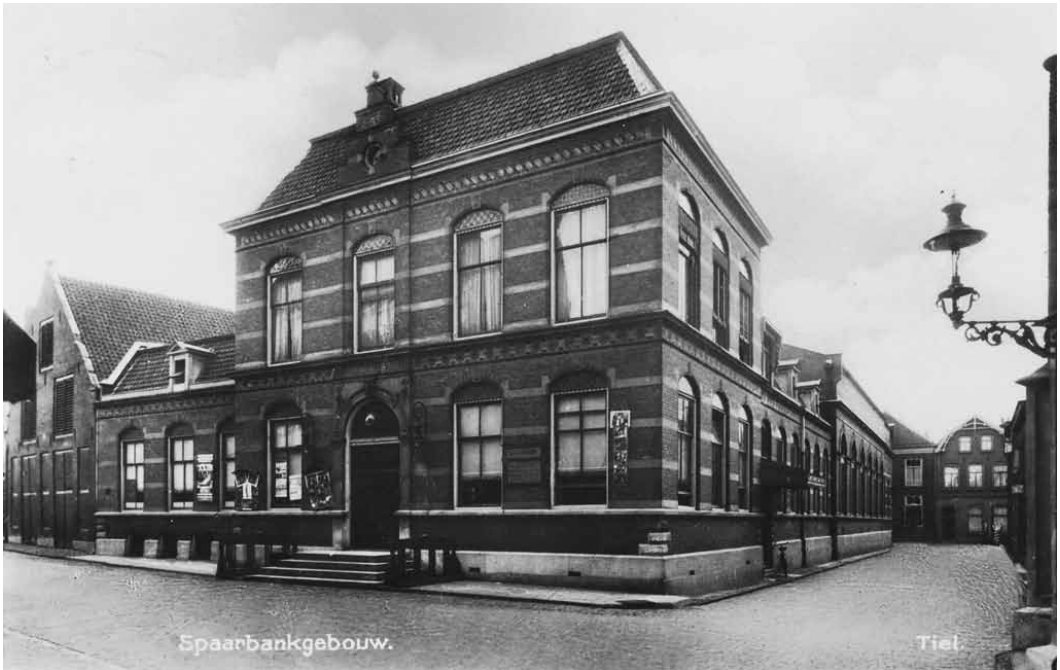
Het Spaarbankgebouw op de hoek van de Sint-Agnietenstraat en de Kerkstraat.
