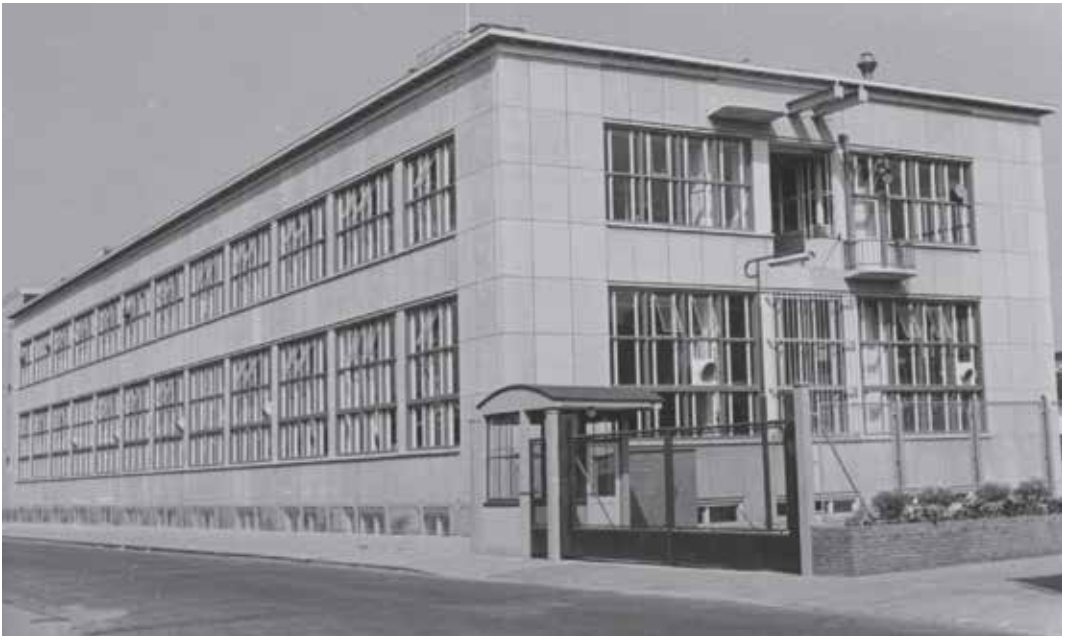
In 1956 werd aan de Binnenhoek deze boilerfabriek van Daalderop gebouwd. Het storten van beton met een persleiding was een novum voor Tiel en trok tot in de nachtelijke uren veel bekijks. (Collectie De Vree en Sliepen)
