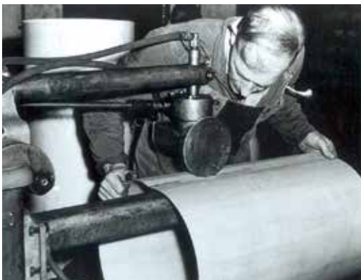
Buigen van een boilerwand bij Daalderop, jaren zestig (Collectie: Flipje en Streekmuseum Tiel)
