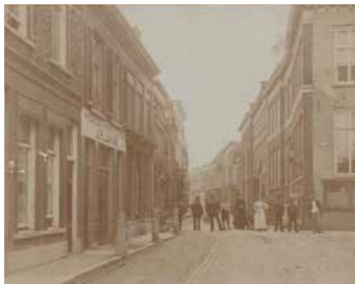
⚠ Gasthuisstraat richting Vleesstraat. Rechts het oude stadhuis. Links werkplaats en winkel van J.K. Loman (Collectie RAR)
