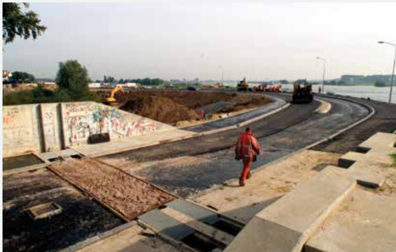
De aanleg van de nieuwe Havendijk in 2001
